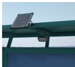
> Instalação no teto
