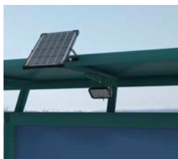
> Instalação no teto
