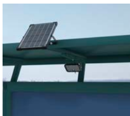
> Instalación en el techo
